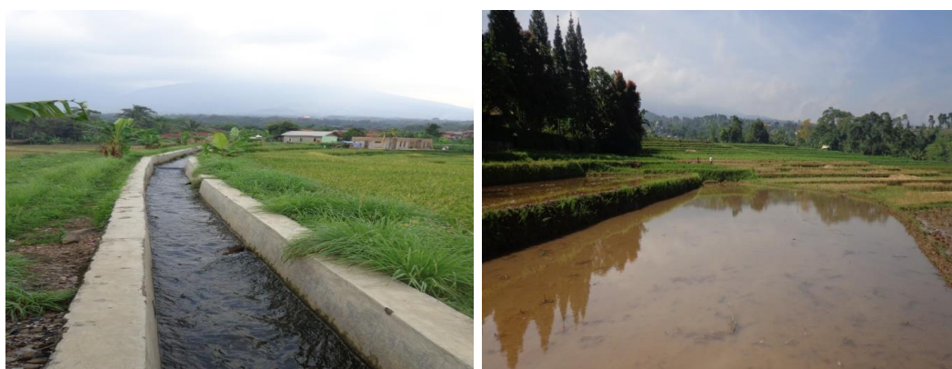
Gambar 13. Saluran irigasi tertier dan kondisi sawah irigasi teknis di Provinsi Bali
