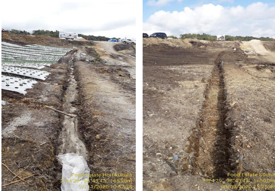
Gambar Penerapan teknologi konservasi tanah dan air. Perbandingan kondisi saluran buntu antara sebelum musim hujan (Gambar kanan) dan setelah periode 1,5 bulan kejadian hujan (Gambar kiri) di lokasi food estate hortikultura, di Kabupaten Humbang Hasundutan, Sumut.
